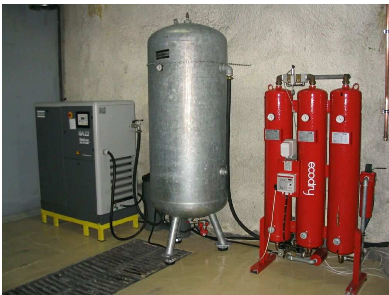
Obrázek 29: Antiradonové zařízení – zleva: kompresor, vzdušník, sušička vzduchu včetně protiprachového filtru.
