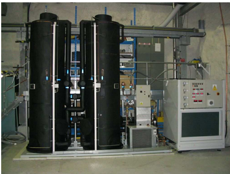
Obrázek 30: Antiradonové zařízení – zleva: nádoby s aktivním uhlím, ohřívací zařízení, chladicí agregát.
